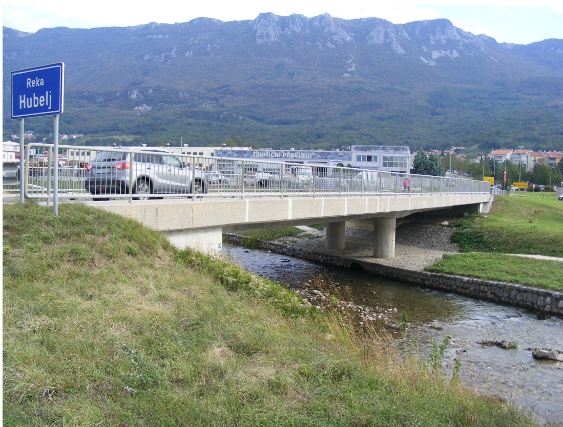
Obstoječi premostitveni objekt preko reke Hubelj
