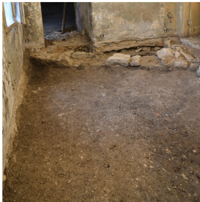
Slika 5.6: Plast SE 1017, ki se naslanja na temelj SE 1004 (foto: L. Duranka).
