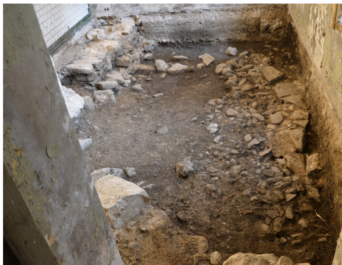
Slika 5.4: Nasutje SE 1022 in nad njim utrditev iz velikih apnenčevih kamnov SE 1021. Pogled proti severu (foto: L. Duranka).
