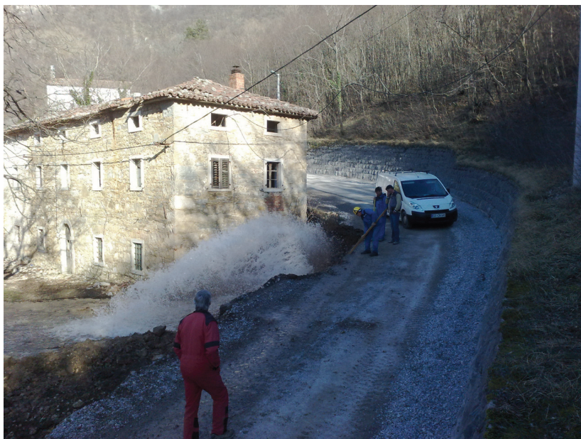
Pomen točne lokacije cevovoda spoznamo šele ob poškodbi cevi in posledično prekinjeni oskrbi s pitno vodo
