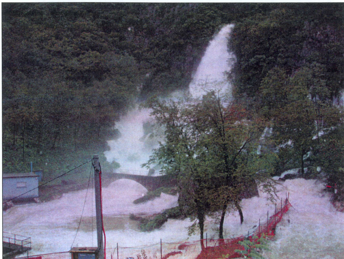
Lokacija: Izvir Hublja – deroča voda je do izliva v reko Vipavo poplavljala in rušila strugo
