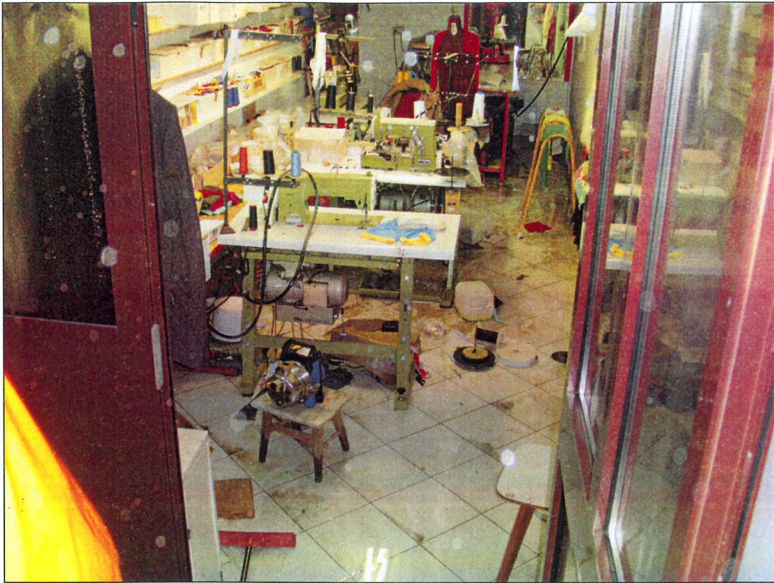
Lokacija: Vilharjeva ulica, Ajdovščina prečrpavanje vode iz večjega števila objektov
