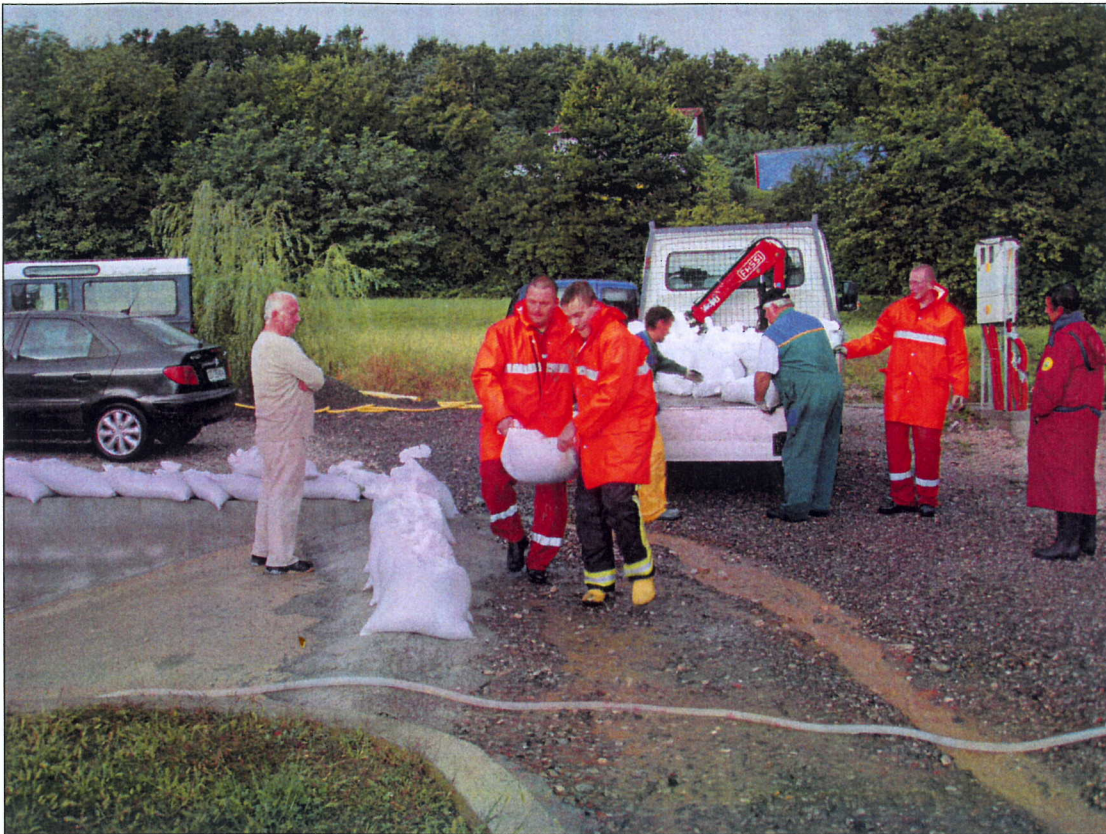
Lokacija: Lokavec 77/F in 77/J, prečrpavanje in postavitve protipoplavnih vreč
