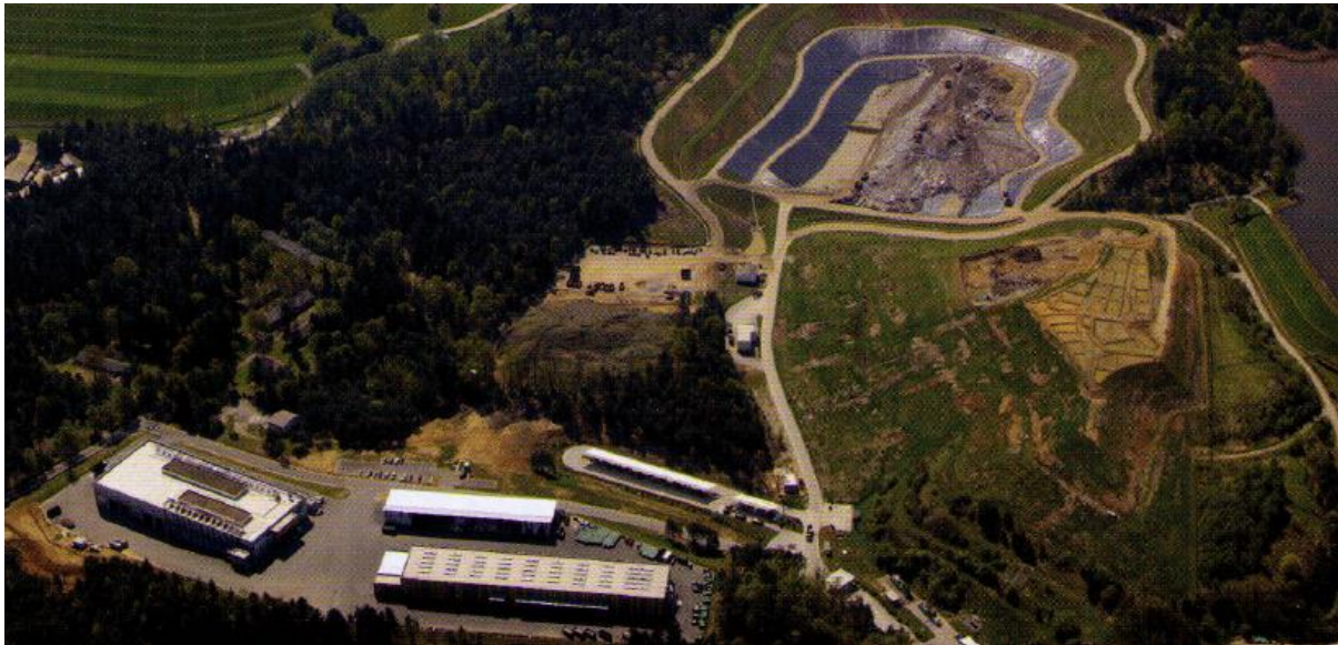
Slika 5: Odlagališče s spremljajočimi objekti, CERO Celje
