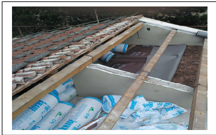
toplotna izolacija podstrešja
