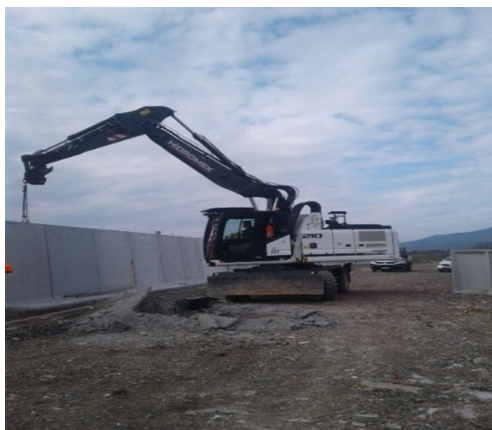
Bager na kolesih med montažo betonskih elementov
