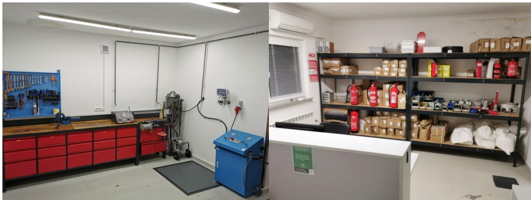
Slika 1 in 2: Prenova delavnice za preventivo.
