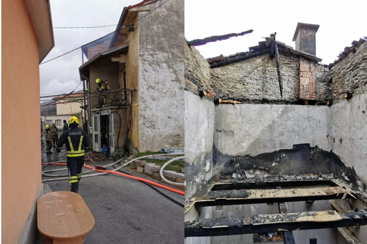
Slika 5 in 6: Gašenje stanovanjskega objekta v strnjenem naselju Lokavec med močno burjo.
