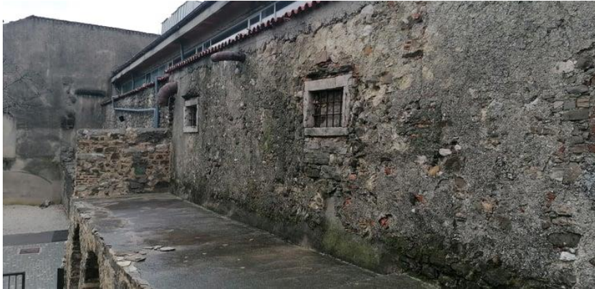
Slika 3: obstoječe stanje vzhodnega obzidja Kastru
